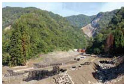
長野県北部地震で崩落した中条川流域
